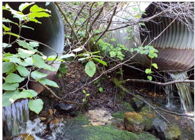
Photo 36. Ponceaux au ruisseau CE-26 (OBS36)
