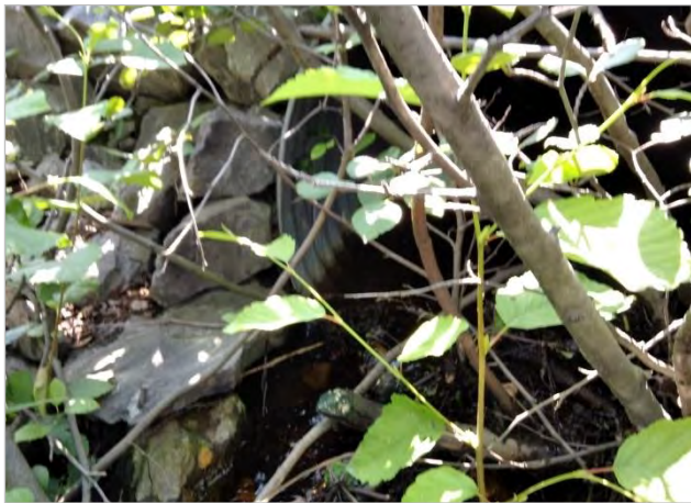
Photo 33. Ponceau au ruisseau CE-23 (OBS22)
