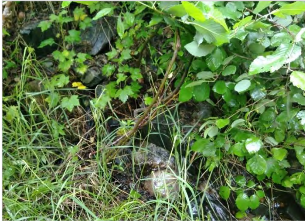
Photo 37. Ponceau au ruisseau CE-9-9 (OBS14)
